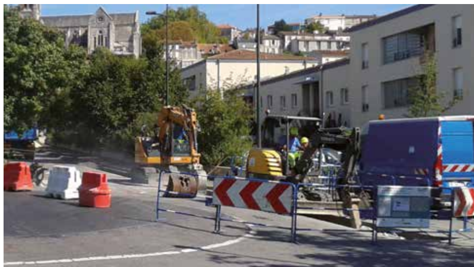
> Travaux rue de Bordeaux, Angoulême. Crédit photo : GAMA / GrandAngoulême
