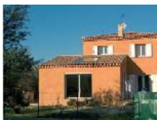
Intégré à la toiture de l'extension
