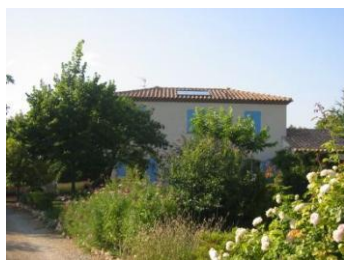
Discret en façade vue de la rue
