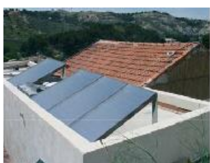
Derrière un mur acrotère en toiture
