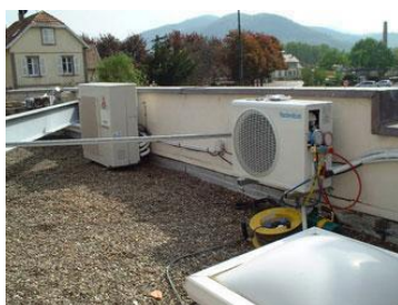
Sur le toit derrière un mur acrotère
