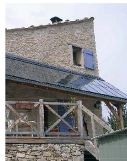
En couverture d'une pergola
