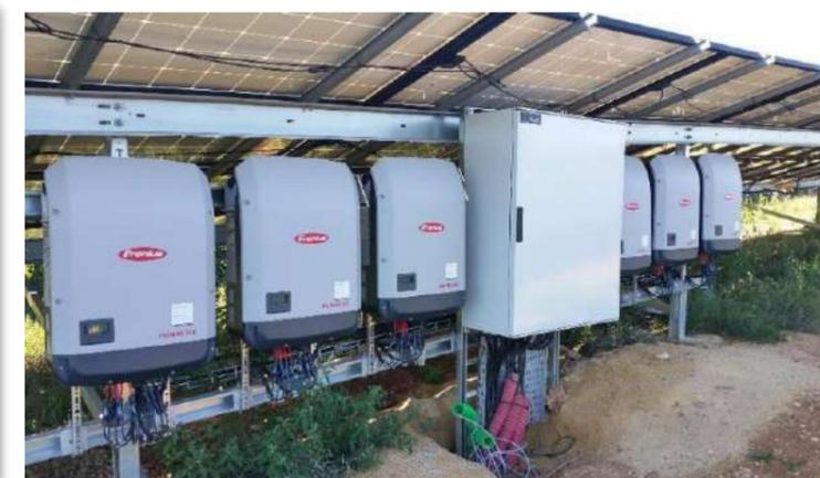
**Boîte de jonction, onduleurs et câbles à l'arrière des panneaux -**
