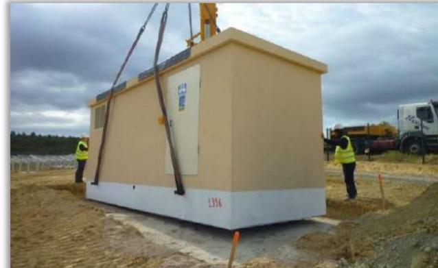
Schéma de dépose des postes préfabriqués - Source : Transfix
