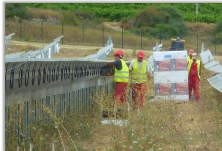
Câblage et interconnexion des modules photovoltaïques – (Source : LUXEL, 2010)
