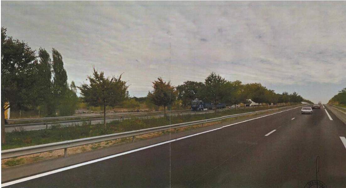
État initial depuis la route nationale n°10 à l'Ouest du site
