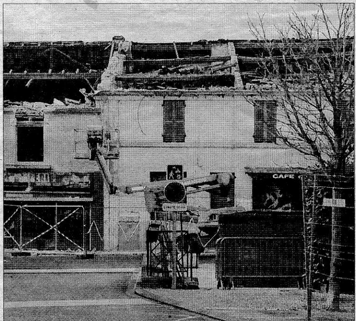
La démolition du bar Le Périgord et la boucherie est inscrite au budget 2019. Photo CL
