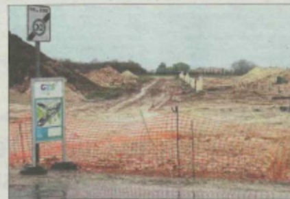
Le chantier des Grandes-Vignes devant être livré à la fin de l'année. Photo C.L.
