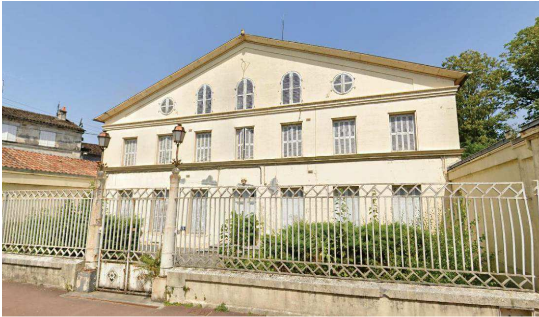
Vue sur l'hôtel de direction depuis l'Avenue Jean Jaurès
