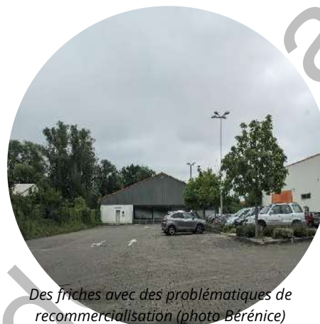
Des bâtiments vétustes, manque de qualité du bâti (photo Bérénice)
