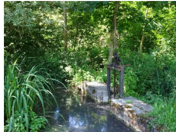
Petite écluse sur l'Echelle à Sers
