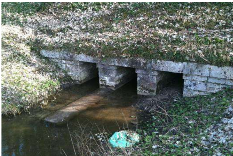
Figure 116 : Ouvrage de franchissement ©Jean-Pierre Sardin – Charente Nature
