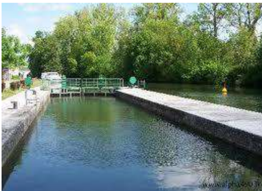
Figure 113 : Ecluse de Basseau à Angoulême sur la Charente ©EPTB
