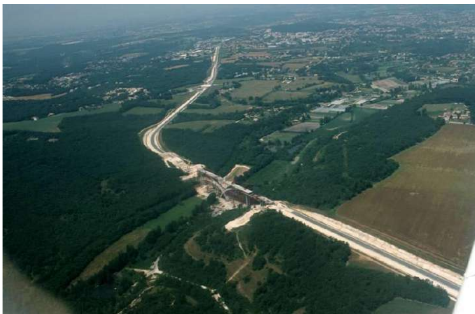
Figure 100 : LGV en construction ©Charente Nature
