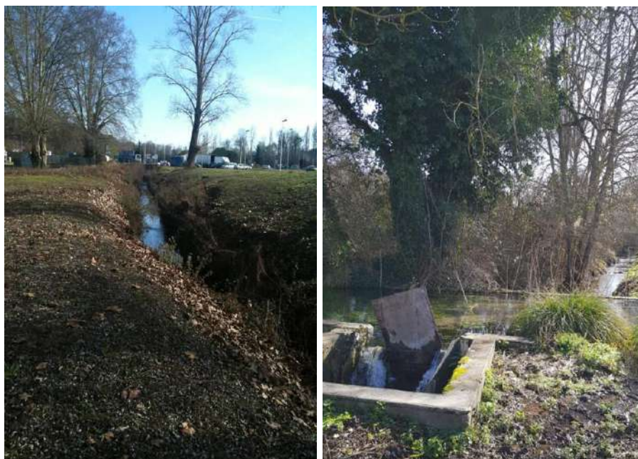
Figure 115 : A gauche : Canalisation des Eaux Claires à Girac ©Jean-Pierre Sardin – Charente Nature A droite : Eaux Claires sur son cours intermédiaire ©Valentin Hortolan
