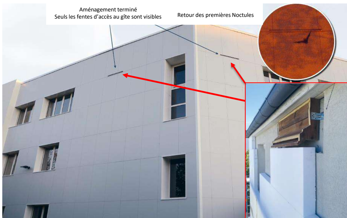
Figure 130 : Aménagement en façade d'un gîte à noctule
