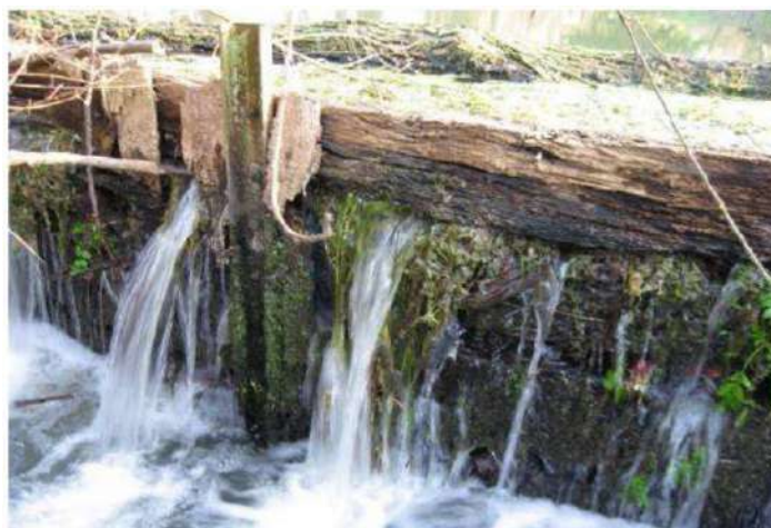
Figure 112 : Seuil à batardeaux sur la Touvre ©Syndicat Intercommunal d'Aménagement Hydraulique et Piscicole du Bassin de la Touvre
