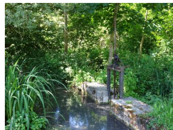
Petite écluse sur l'Echelle à Sers
