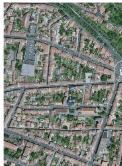
RUE SAINT-ROCH / RUE MONLOGIS / RUE CHÂTEAUBRUN ANGOULÊME
