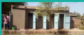
Projet Kambavenir : construction, utilisation et entretiens des latrines. Burkina Fasso.
