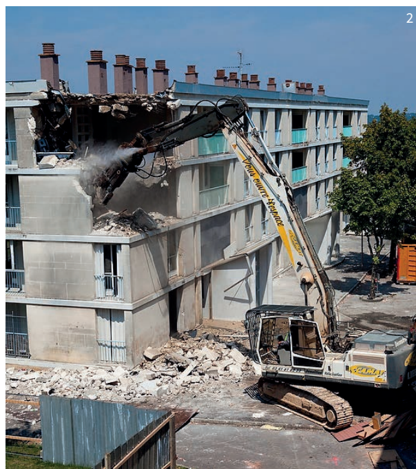
1 - « Casser » l'image des quartiers : la démolition d'une partie des « 850 » à Ma Campagne, Angoulême © direction Cohésion territoriale et appui aux communes - GrandAngoulême. 2 - La démolition du bâtiment A en cours au Champ-de-Manœuvre à Soyaux © G. Truffandier
