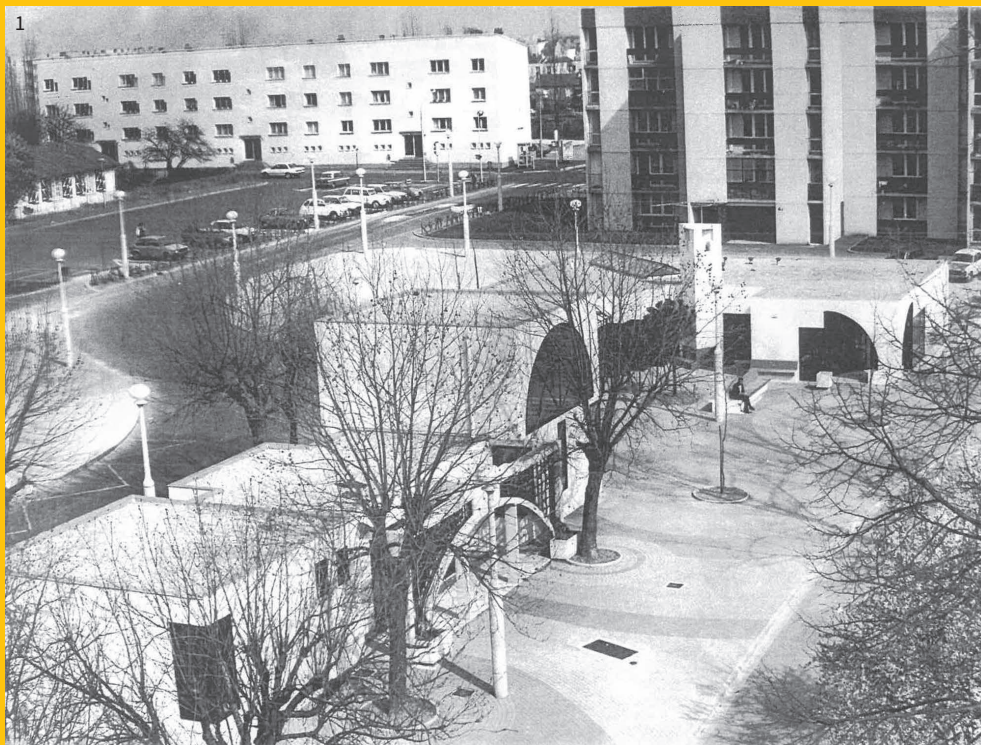
1 - Basseau dans la seconde moitié des années 1970 - La mairie annexe (disparue) au premier plan et les immeubles à l'arrière-plan © AM Angoulême
