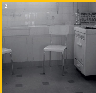
2 & 3 - Appartement témoin à La Grand-Font (juin 1954) © C. Saffier de Bard Les 500 logements offrent tout le confort moderne pour l'époque : électricité, eau courante, chauffage central, ascenseur, antenne TV collective.
