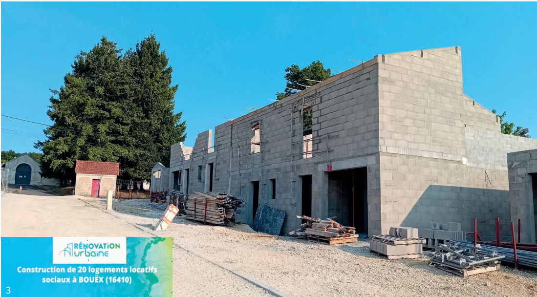
3 - Construction à Bouëx de logements sociaux locatifs dans le cadre de la rénovation urbaine © PAH/GA Lotissement en construction dans le bourg (été 2025)
