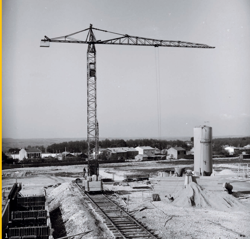
1 & 2 - Chemin de grue et barre d'immeubles au Champ-de-Manœuvre à Soyaux , collection Auzéral - Mairie de Soyaux Industrialiser la construction pour bâtir plus vite et moins cher
